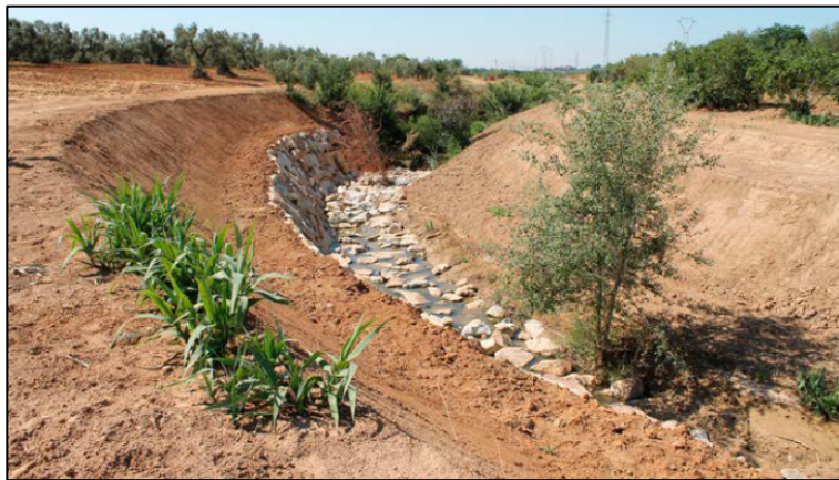
Foto 3. Trabajos de restauración del cauce del arroyo Riopudio. Fuente: Confederación Hidrográfica del Guadalquivir (2009).
